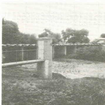
Limnógrafo, sección y estructura de aforos Vista desde la margen izquierda
