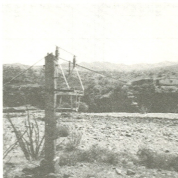
Estructura y sección de aforos Vista desde la margen izquierda
